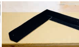
6. Den Klebestreifen aufklappen und die geklebte Innenecke zur Seite falten
