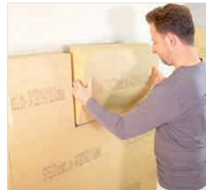
Verlegung kleinformatiger stumpfer Platten
