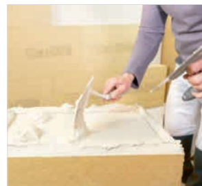
Dämmplatte ankleben auf unebenem Untergrund im Punkt-Wulst-Verfahren
