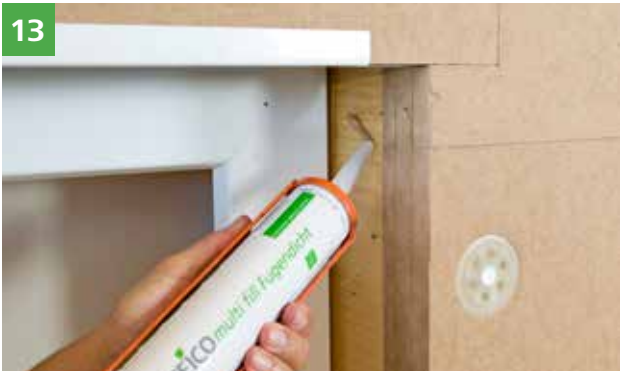
13 Aufbringen von STEICOmulti fill Kleberaunen in die Holzrahmen-Konstruktion, um einen sicheren Halt der Laibungsplatte zu gewährleisten.
