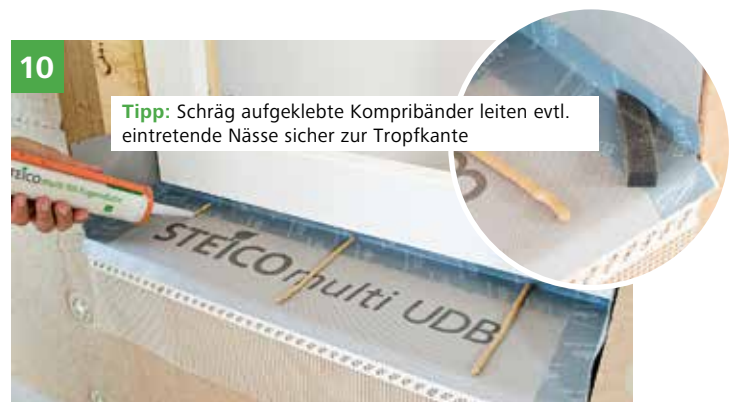
10 Auftragen von STEICOmulti fill Kleberaupen e \leq 30 cm für die elastische Befestigung der Fensterbank.
