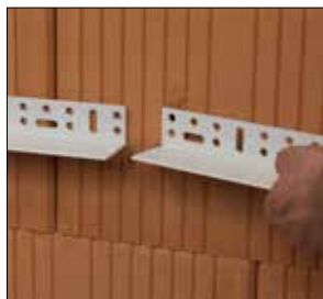
Winkelschiene anbringen
