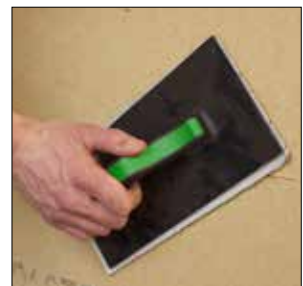
Plattenversätze beischleifen
