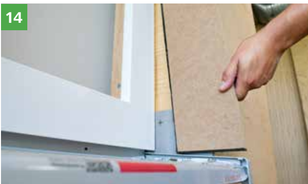
14 Einsetzen der Laibungsplatte bündig zur Außenkante der WDVS-Fassade TIPP: Ggf. Fensterstockverbreiterung einplanen.
