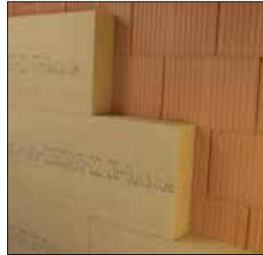
Verlegung kleinformatischer stumpfer Platten
