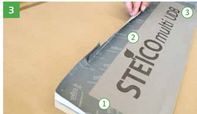
3 Im Anschluss werden die STEICO multi tape F Klebestreifen so auf dem Dämmkeil angebracht, dass eine dreiseitige „Wanne“ ausgebildet wird.
