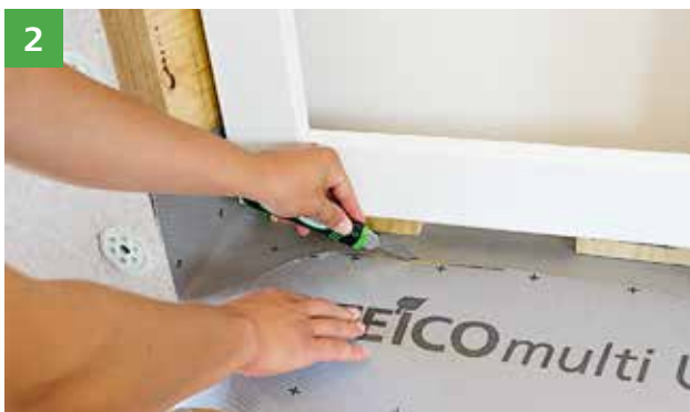
2 Der Einbau erfolgt auf der Unterdeckbahn. Vor Montage von STEICO fix wird die Bahn „halbmondförmig“ zurückgeschnitten (vgl. Bild 5).
