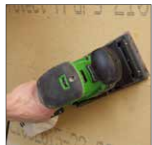
Plattenversätze beischleifen
