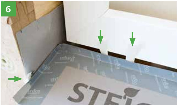
6 Einbau des STEICOfix Dämmkeils. TIPP: Trennpapier zurückfalten, es kann später leichter entfernt werden.
