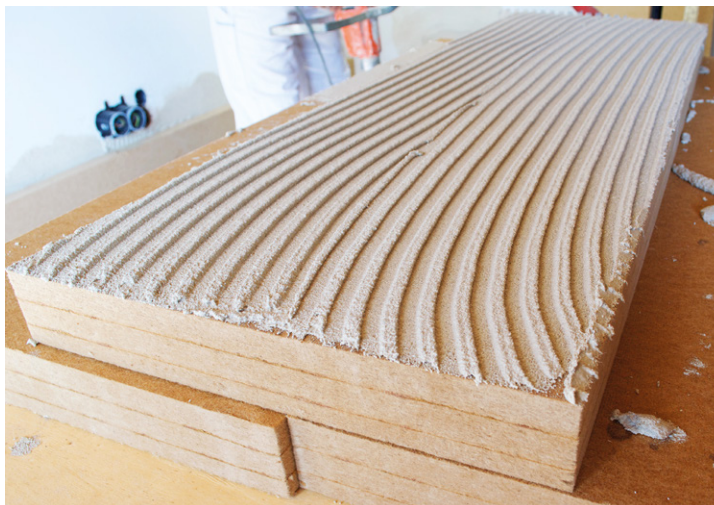
Eine 6 cm starke STEICOinternal verbessert den Außenwand-U-Wert von 1,3 auf 0,44. Wichtig ist eine vollflächige Verklebung. Fotos: STEICO
