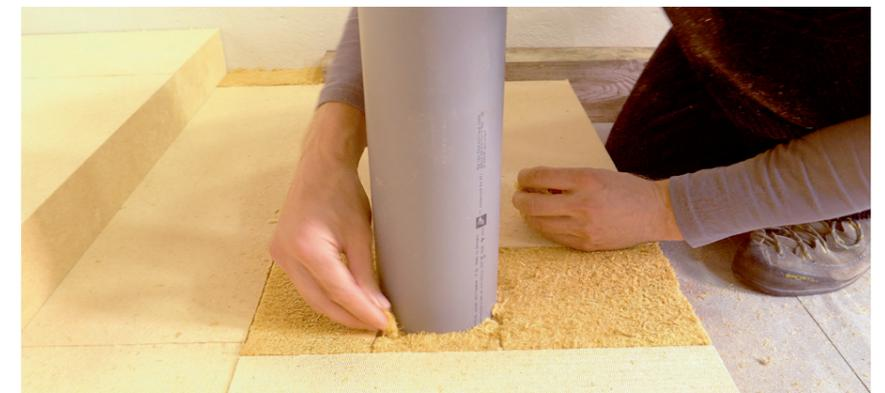
2a,b | Bei kniffligen Anschlüssen, wie z. B. an ein freistehendes Entlüftungsrohr, wird der Bereich zwischen der robusten STEICOtop mit der flexiblen STEICOflex gefüllt.
