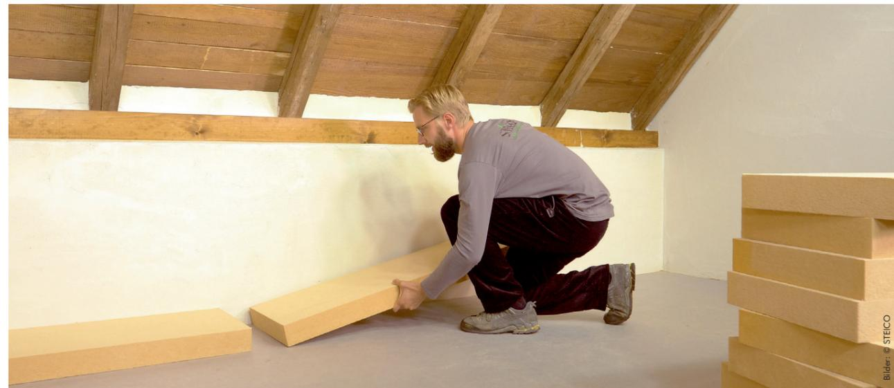
1 | Die Holzfaser-Dämmplatte STEICOtop hat ein handliches Format, lässt sich problemlos ins Dachgeschoss bringen und dort dann schnell verlegen.
