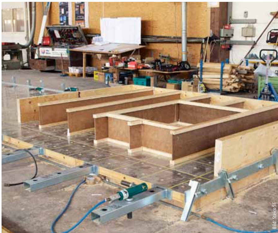
Stegträger mit einer Höhe von 360 mm im Regelbereich und Furnierschichtholz im Bereich der Schwelle und an den hoch belasteten Wandenden auf dem Elementtisch.
