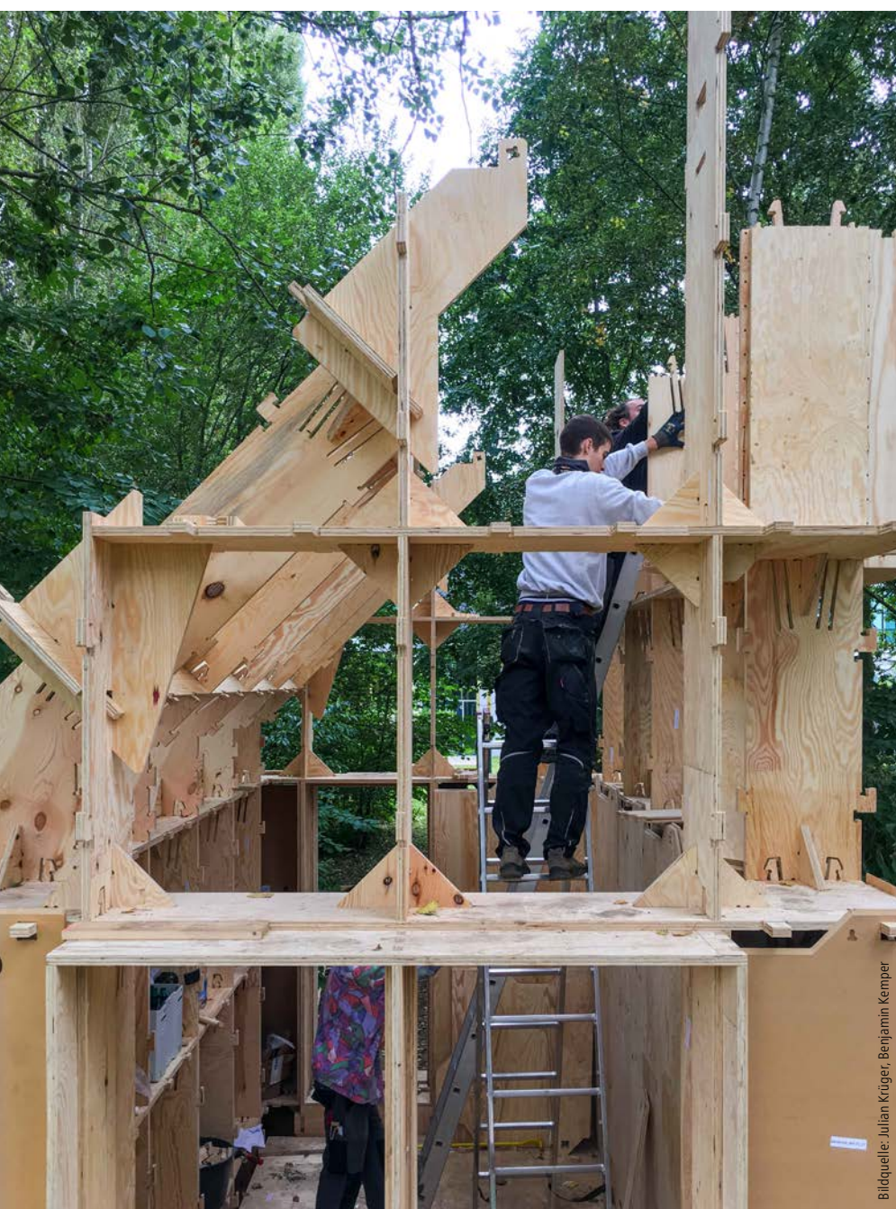
Das durchdachte Bausystem ermöglicht es, die exakt gefertigten Elemente ohne Werkzeuge und ohne Verbindungsmittel einfach zusammenzustecken.
