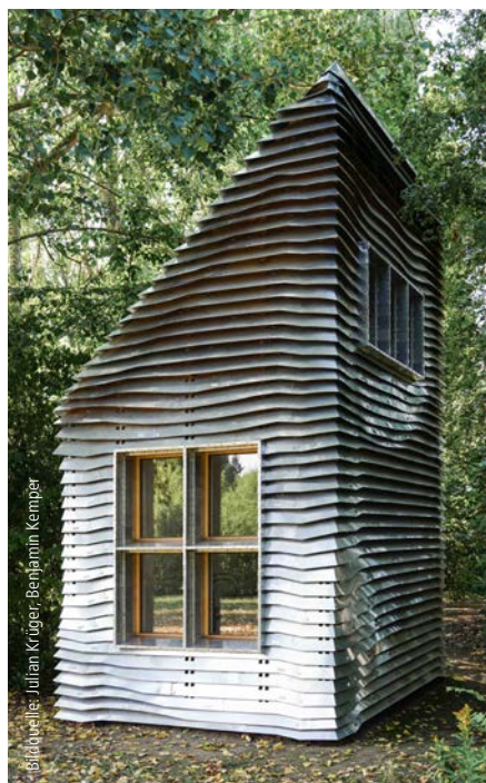
Die Fassade mit ihren horizontal aufgesteckten Lamellen aus recyceltem Aluminium verleiht dem Digital House eine futuristische Anmutung.
