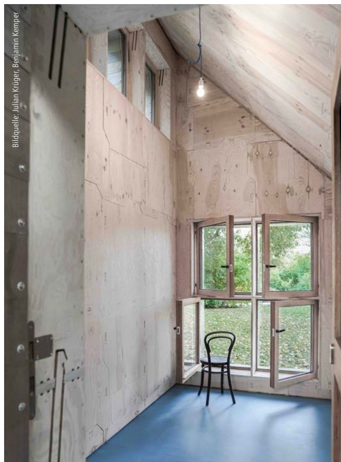
Die Oberflächen des Raums sind mit puzzleartig zugeschnittenen Furnierschichtholzplatten bekleidet, die das Tragwerk zusätzlich aussteifen.
