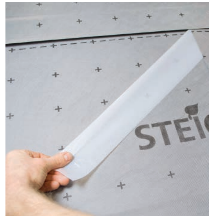
Verarbeitung im Detail: Die Überstände der aufkaschierten Unterdeckbahn sind selbstklebend. Zuerst werden die vertikalen Stöße verklebt, dann die horizontalen
