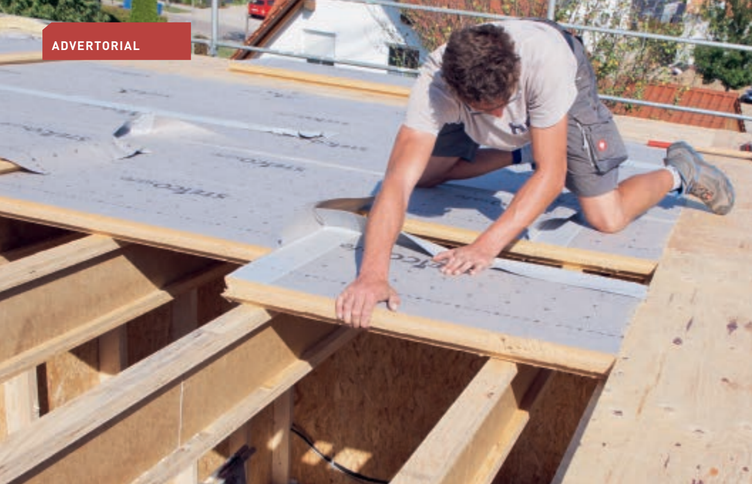
Wirtschaftlich: Mit der Holzfaser-Unterdeckplatte Steico Safe lässt sich ein regensicheres Unterdach in nur einem Arbeitsschritt einfach und schnell herstellen
